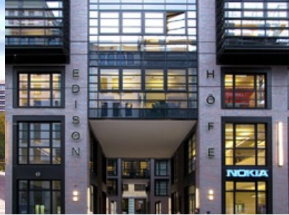
Nokia Building en Edison Höfe. Alemania.
